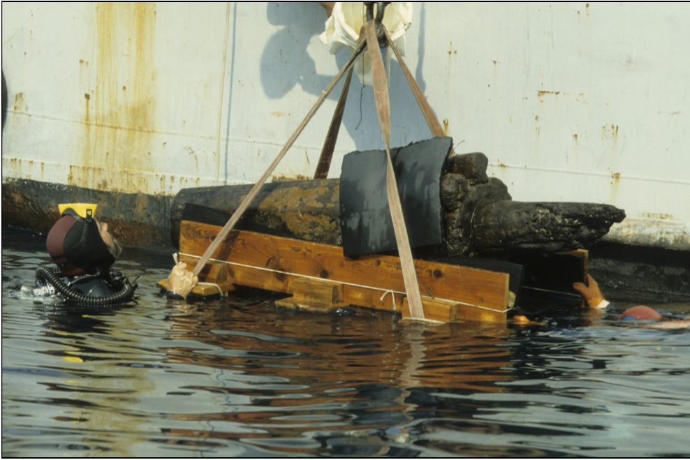
Figure 15 - Récupération du cabestan 1983
