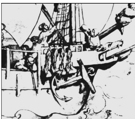
Figure 8 - Ancre à son poste de mer 11
