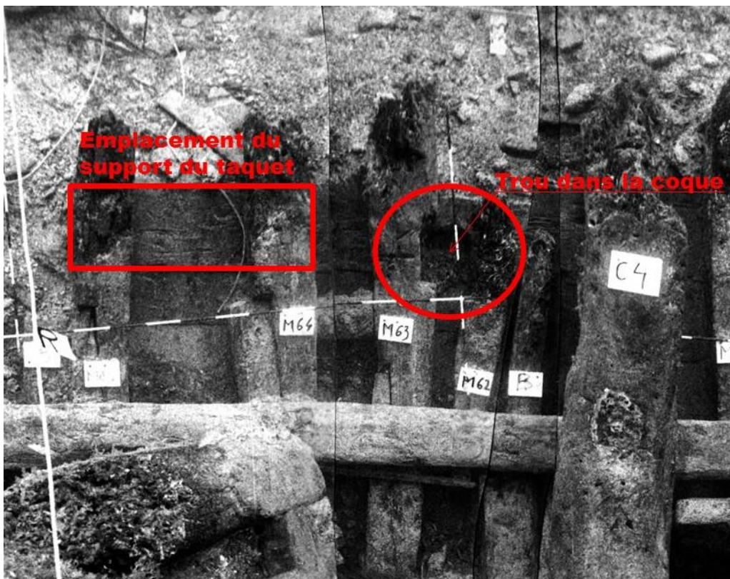
Figure 40 - Montage photographique montrant l'emplacement du taquet et celui du trou pratiqué dans le bordé.
