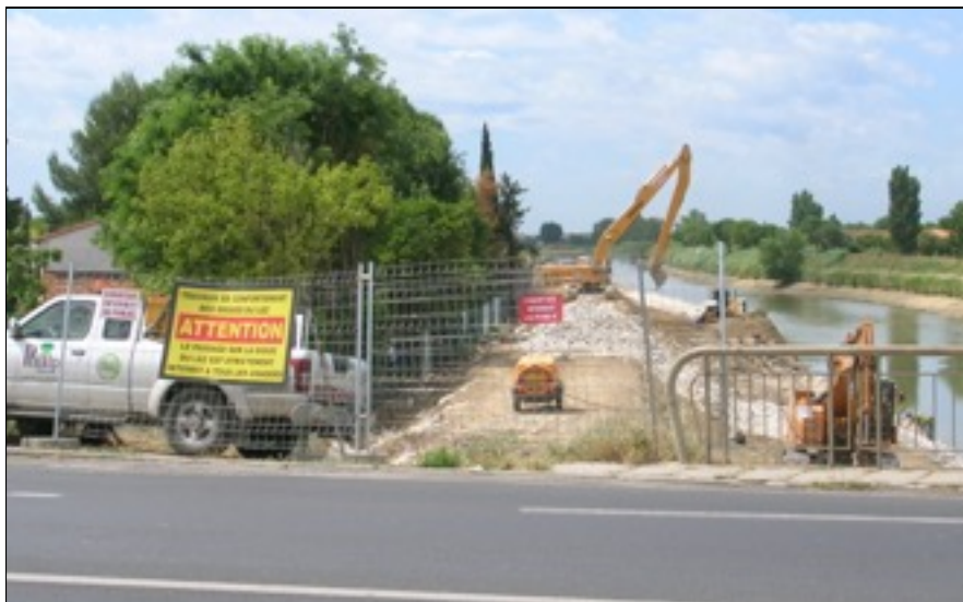
Figure 1 : Travaux de renforcement des digues (Photo : Durand S. 2009).
