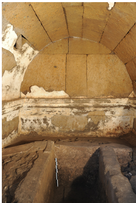
FIG. 7. Photo de l'intérieur de la chambre funéraire, vue depuis l'ouest (cliché CJB, USR 3133 CNRS – EFR).
