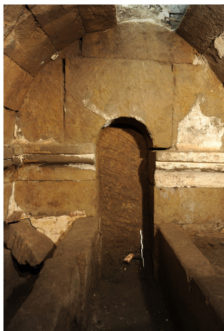
FIG. 8. Photo de l'intérieur de la chambre funéraire, vue depuis l'est (cliché CJB, USR 3133 CNRS – EFR).
