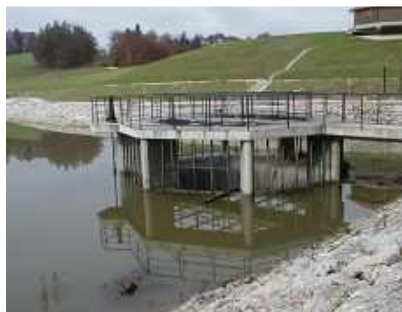
Figure 2 : Barrage de Drtijsca (Slovénie) : plan d'eau permanent contrôlé par une prise 'tulipe'
