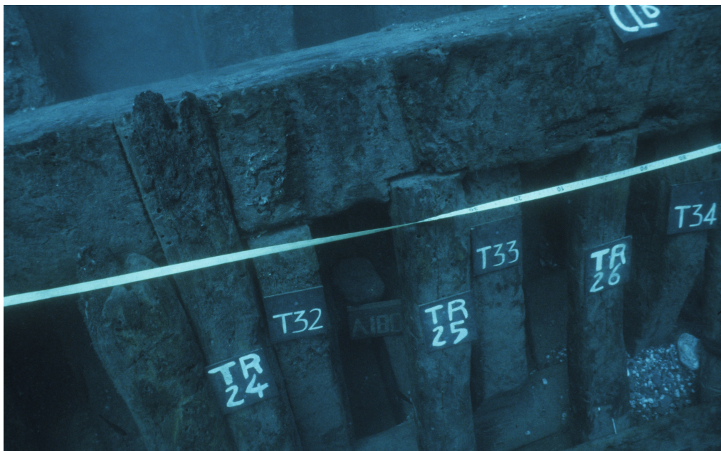
Figure 9 - Vue de l'emplacement de l'encoche avant, observée en 1987.
