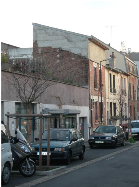
Montreuil 2015 – réaménagement ponctuel d'une voirie et des stationnements
