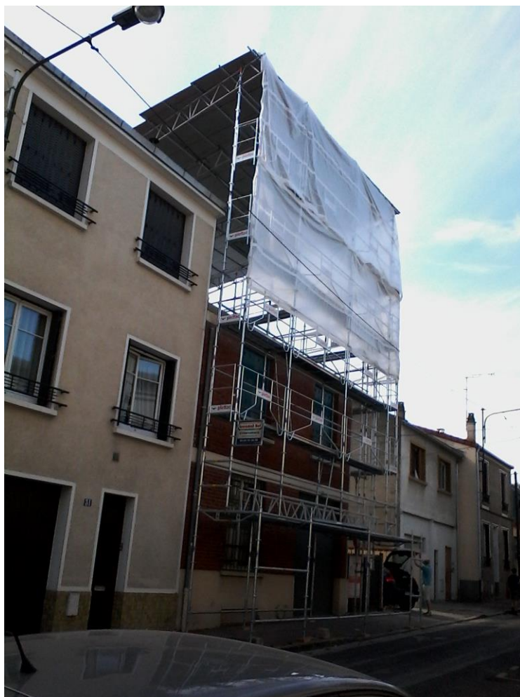
Montreuil 2016 – transformation d'un R+1 en R+3 dans un secteur pavillonnaire
