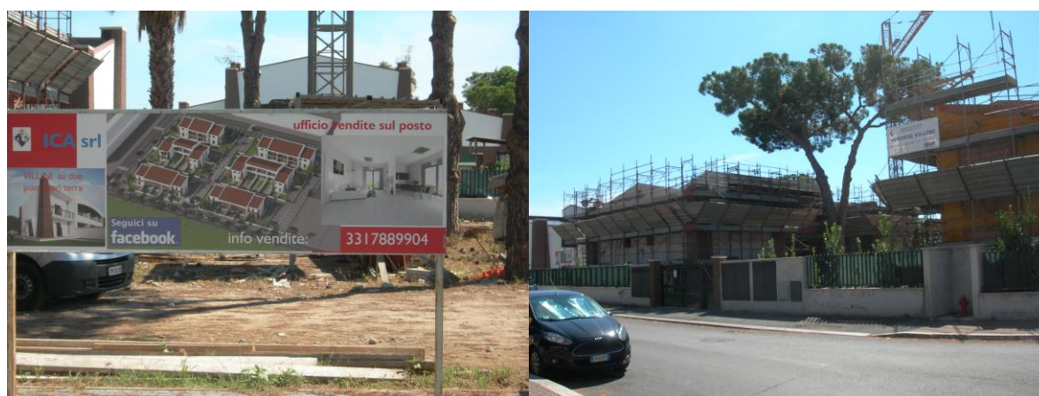
Rome 2016 – nouveaux projets en cours dans l'ancienne zone illégale d'Infernetto
