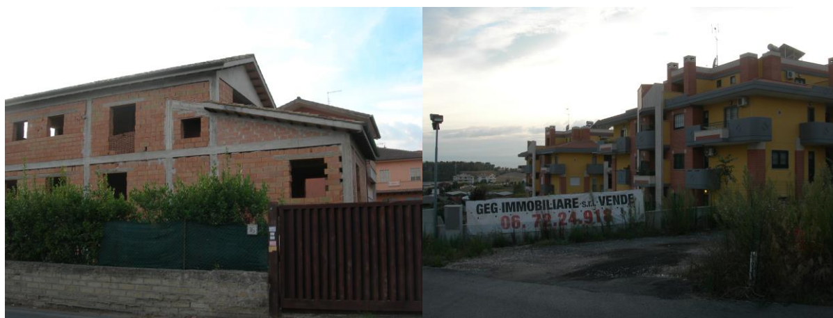
Rome 2016 – Massimina – construction individuelle (gauche) et gros collectif de logements (droite)
