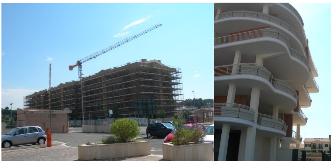
Rome 2016 – Torrino Mezzocammino – Grands projets de construction en cours
