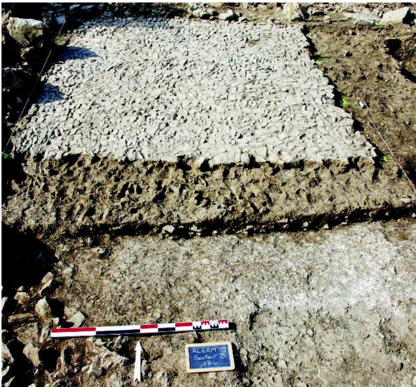
Fig. 5 Alès, oppidum de l'Ermitage. Une couche de nivellement, épaisse couche de terre brune, a été mise en place avant le statumen (cliché F. Olmer, CNRS Lattes).
