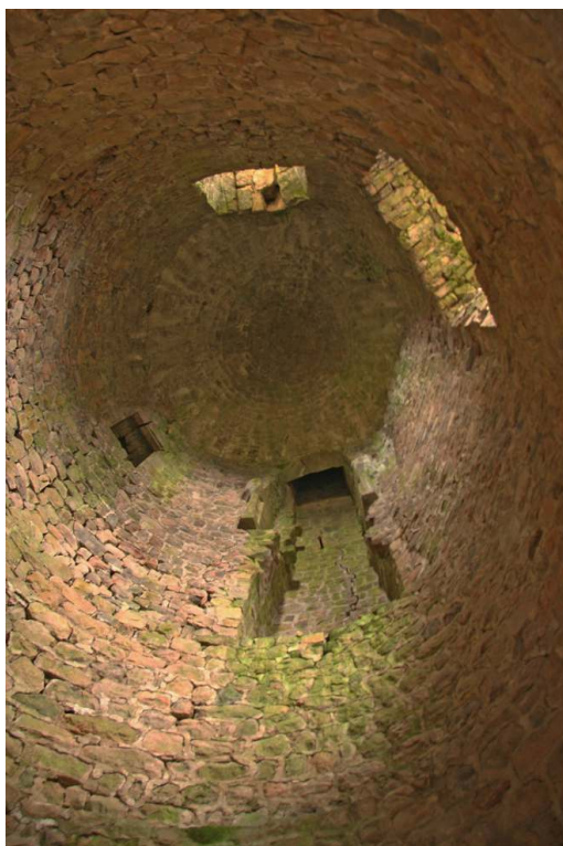
Fig. 3 – Dunières (Haute-Loire), tour dite « de Joyeuse ». Vue intérieure de la tour depuis la base (cl. M. Bizri).
