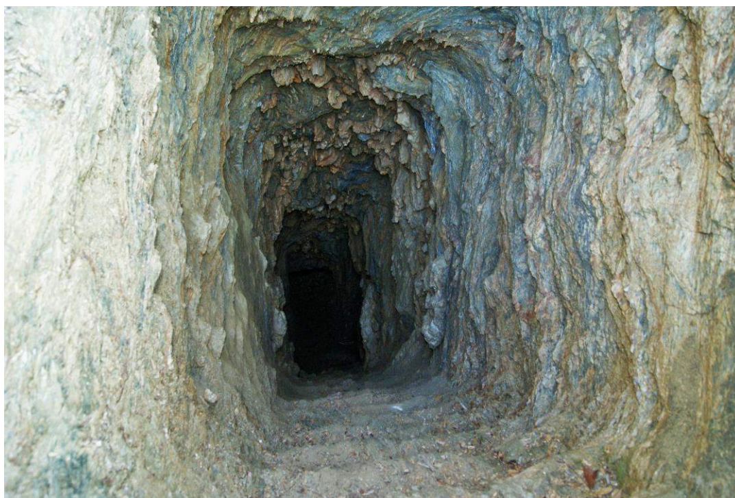
Fig. 11 – Vue de la série 2 de la Galerie n°1 (cliché L. Roche)
