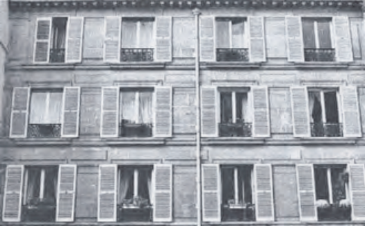
Fig. 1 : Façade du 13, rue Linné, Paris. ▲
