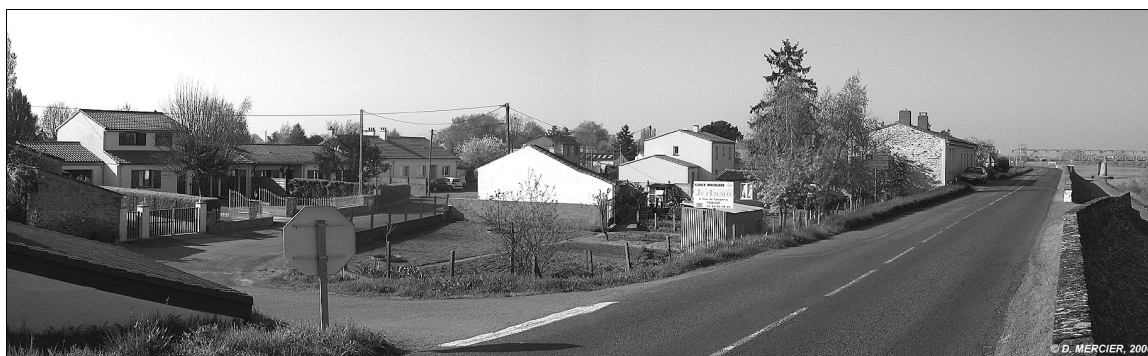
Photos 21 et 22 : Saint-Julien-de-Concelles au village du Ruaud en amont du pont de Thouaré.
