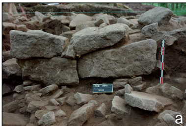
Fig. 9 : Parement nord de la porte (fouille 2015) a. Segment MR 1208 b. Segment MR1209 c. Vue générale depuis le sud-ouest
