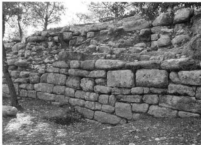
Fig. 174 – CADENET, oppidum du Castellar. Zone 8000 : fondations de la courtine orientale, extrémité nord (D. Isoardi).
