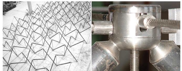
Fig. 3. La grille de Tenségrité Tensarch à nœuds fixes
