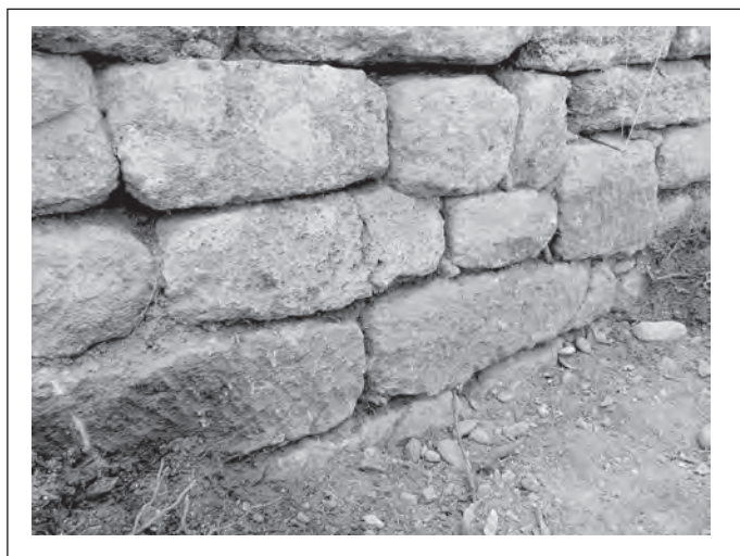
■ Figure 15 – Traces d'outils sur les blocs inférieurs du parement externe. Portion orientale de la courtine – zone 7 (cliché D. Isoardi, 2007).
