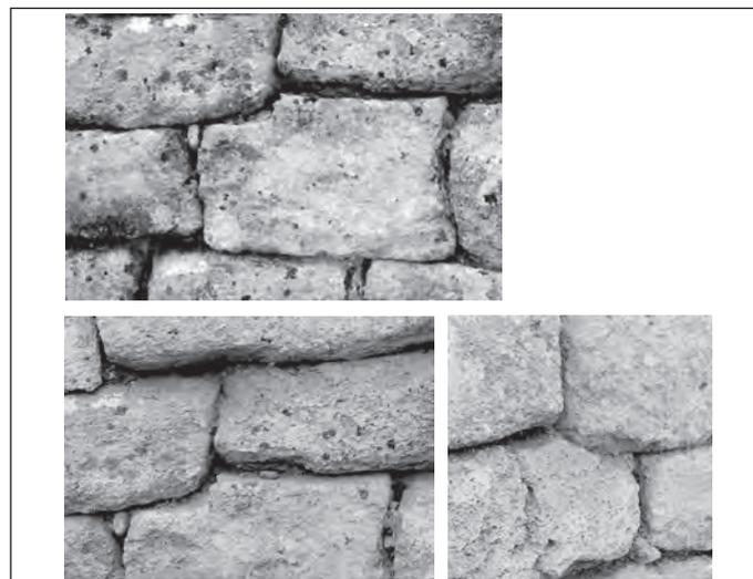
■ Figure 17 – Blocs avec décrochements, sur le parement externe (portion orientale de la courtine – zone 7). (Cliché D. Isoardi, 2007).
