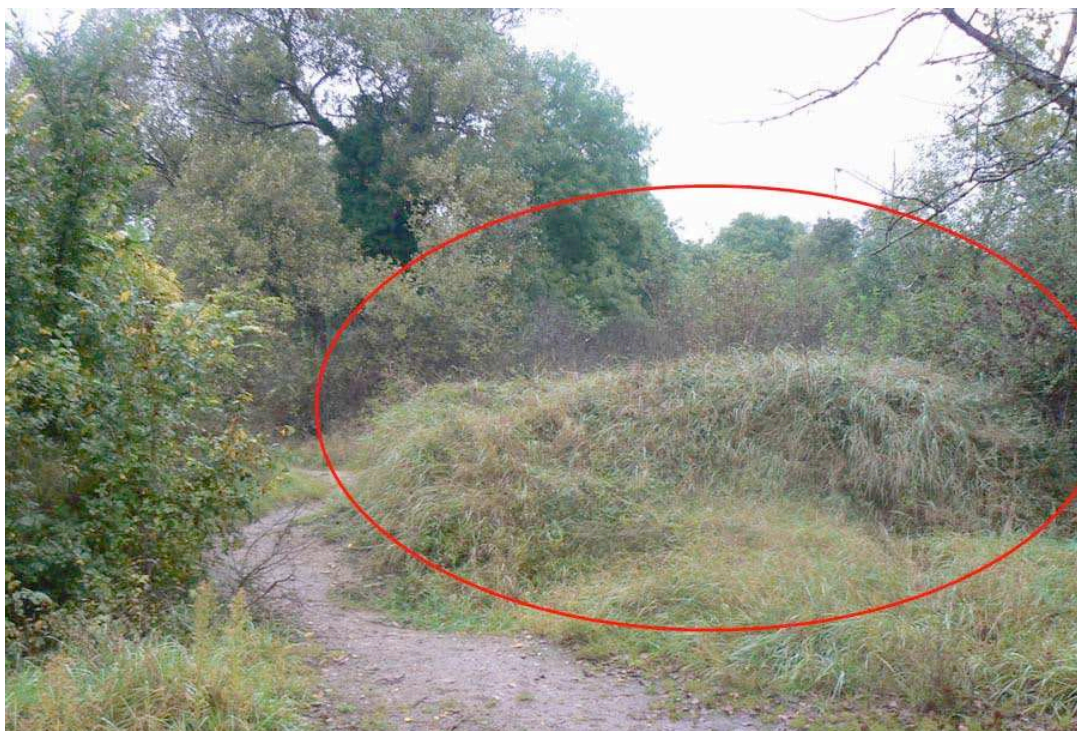
Figure 16 : Anciennes levées de franc-bord, situées à plus de 200 m du bord de la Loire (bec d'Allier).
