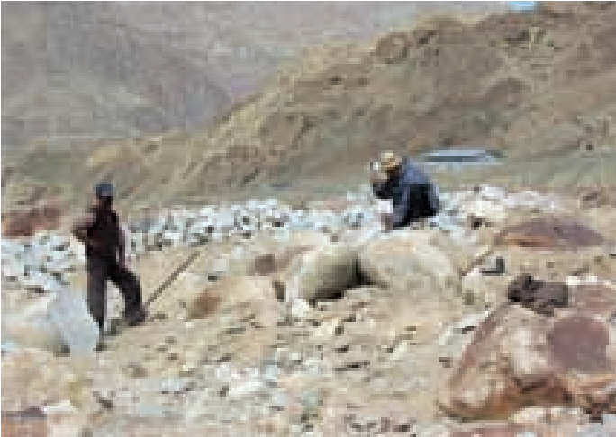
III. 7. Travailleurs saisonniers à l'ouvrage sur le site d'Alchi, (L / AZT), les amas de pierres brisées rendent compte du nombre de roches déjà démolies.
