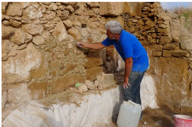
Fig. 91. Application du nouvel enduit après retrait de l'ancien.
