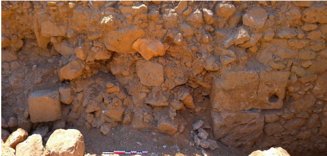
Fig. 42. Lacune du mur entre des blocs taillés au Nord (à gauche) et deux assises formant un coup de sabre au sud (à droite). Il s'agit vraisemblablement d'un passage vers l'Est. La pierre de la 2 e assise porte un anneau rupestre. Vue vers l'Est.
