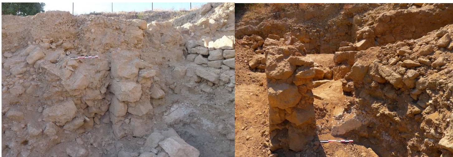
Fig. 30 et 31. Le mur M18 en coupe avant et après retrait du remblai. À droite, bloc avec enduit peint en place. Vues vers l'Est.
