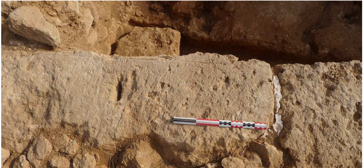
Fig. 64. Lit d'attente du parement Nord du bâtiment 2 avec trou de pince, ligne de pose et mortier de plâtre 2. Nord en haut
