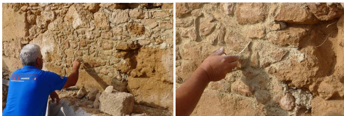
Fig. 92 et 93. Enlèvement au grattoir du nouvel enduit en surplus et détail.
