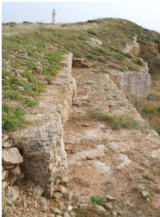
Fig. 9. Assise préservée du rempart Ouest de Paphos fondée sur la roche nivelée au-dessus du probable port occidental. Vue vers le Sud. ©Cl. Balandier
