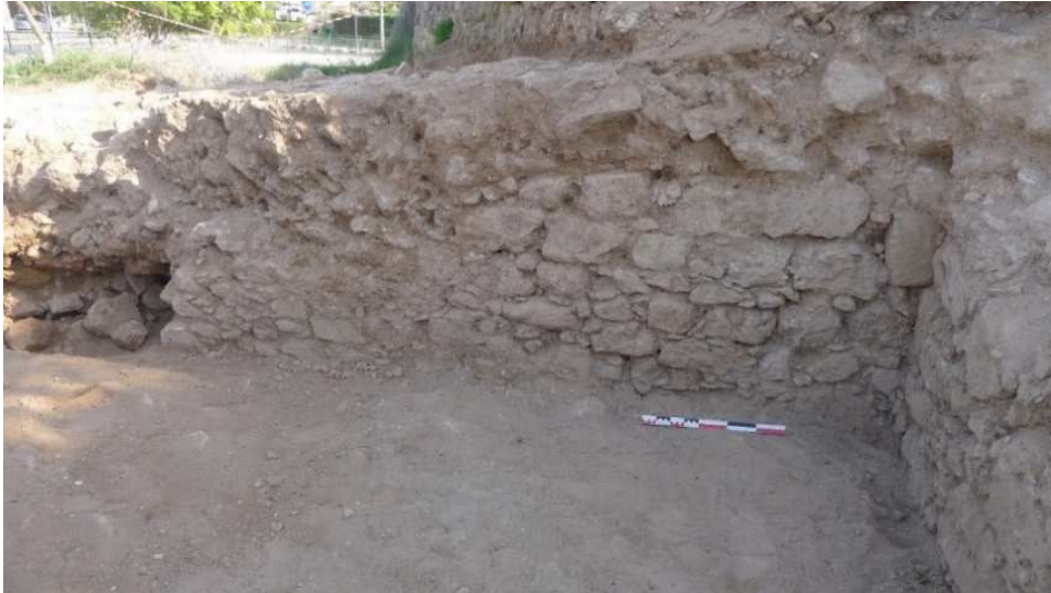
Fig. 35. Face du mur de soutènement Est: limite orientale du bâtiment, recouvert par une rue médiévale. Vue vers l'Est.
