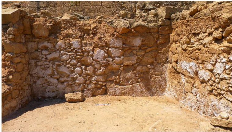
Fig. 40. Espace 5. Niveau de départ de la fouille en 2016 (niveau d'arrêt 2015). Vue vers le Sud.
