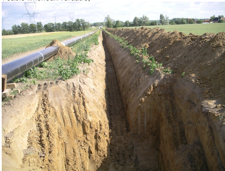
Illustration 31 - Puits de franchissement du chemin au sommet de la dune du Câtelet, et vu de la tranchée vers le sud et la prairie humide
