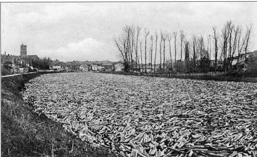
Fig. 2 – Arrivée du grand flot à Clamecy (cliché P. Bertin, autorisation gracieuse de l'auteur).
