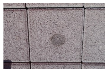
Figure 2 : Pavés en béton de ciment poreux.
