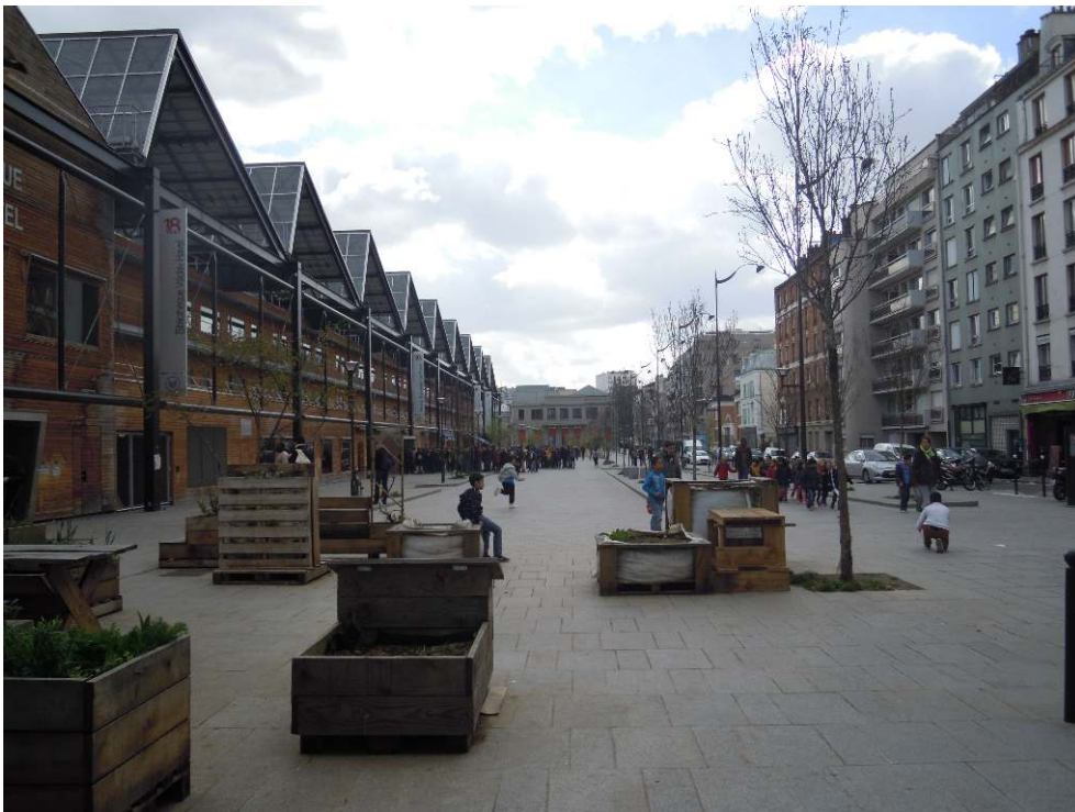
Figure 1. La halle Pajol côté place, avec les entrées de la bibliothèque et de l'auberge de jeunesse
