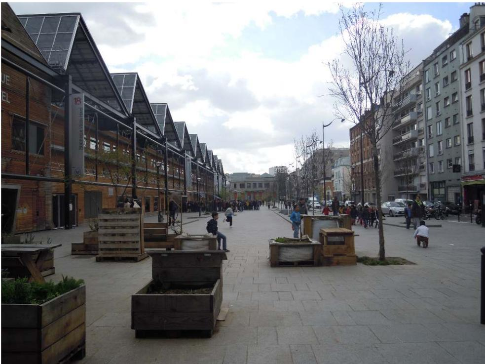
Figure 2. La halle Pajol côté jardin. La structure métallique en shed ajourés abrite un jardin et supporte des panneaux photovoltaïques
