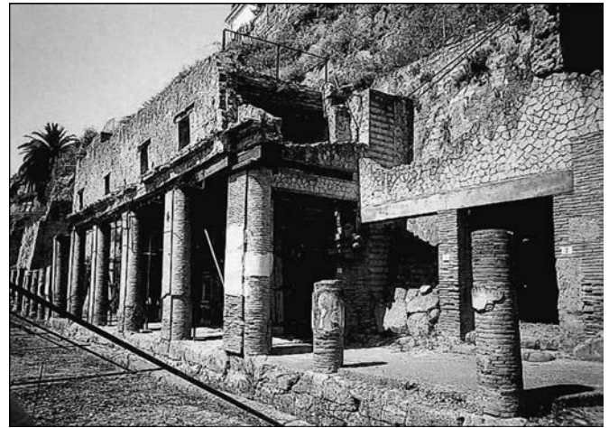
Fig. 14 – Herculanium. Portique constitué de piliers avec des colonnes engagées en brique et surmonté d'un étage (d'après Petit, Brunella dir., 2005, p. 108).
