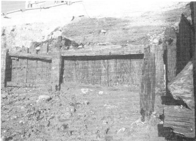
Fig. 8 : Façade des sections 721a et 721b (ensemble 495) © Patrick Ernaux, Inrap.
