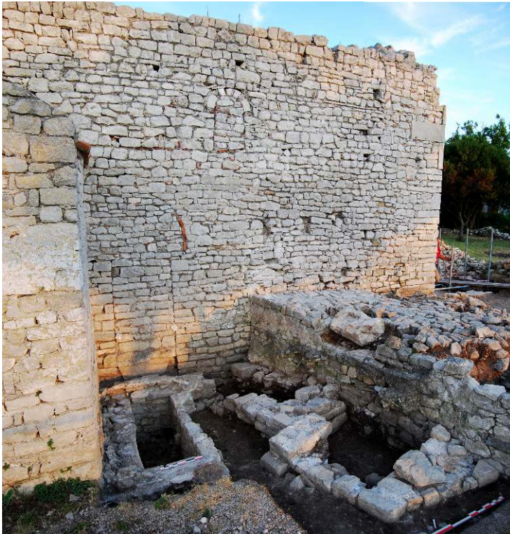
Fig. 12 – Caveau maçonné en situation privilégiée devant le passage roman et mur oriental du bâtiment, avec son escalier, adossé à l'église.
