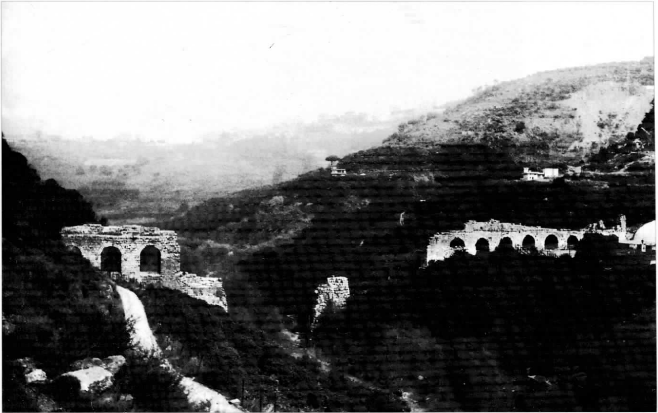
Pl. I. 1. Le pont-aqueduc vu du sud.
