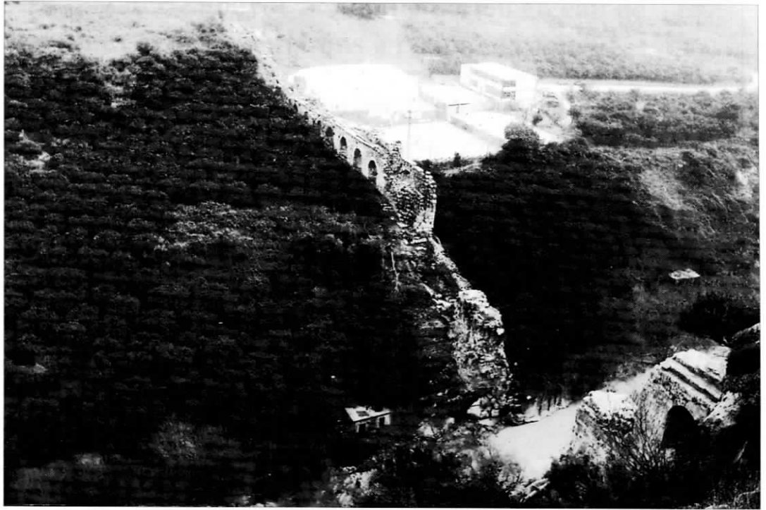
Pl. I. 2. Vue du pont-aqueduc prise de la falaise de Dahr el Chir.
