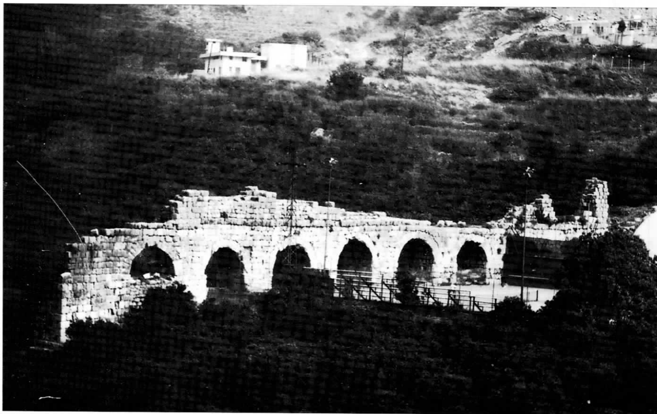
Pl. V. 2. Pont-aqueduc: les arches du deuxième niveau du bloc est, face sud.
