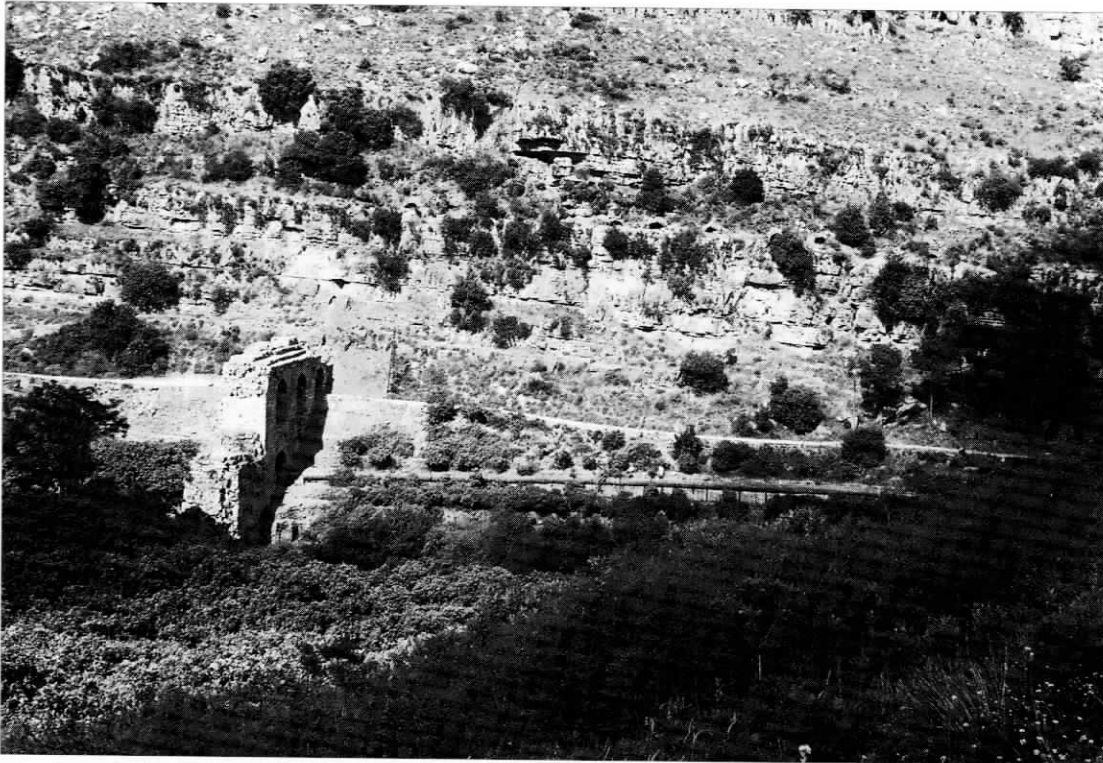
Pl. XI. 1. Vue sur la falaise de Dahr el Chir avec le bloc ouest et les arcs de voûte.
