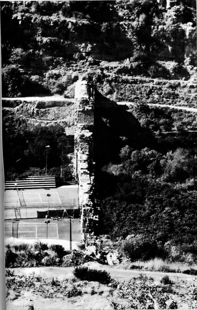
Pl. IV. 1. L'implantation du pont-aqueduc: vue du sommet de la falaise à l'est. base.
