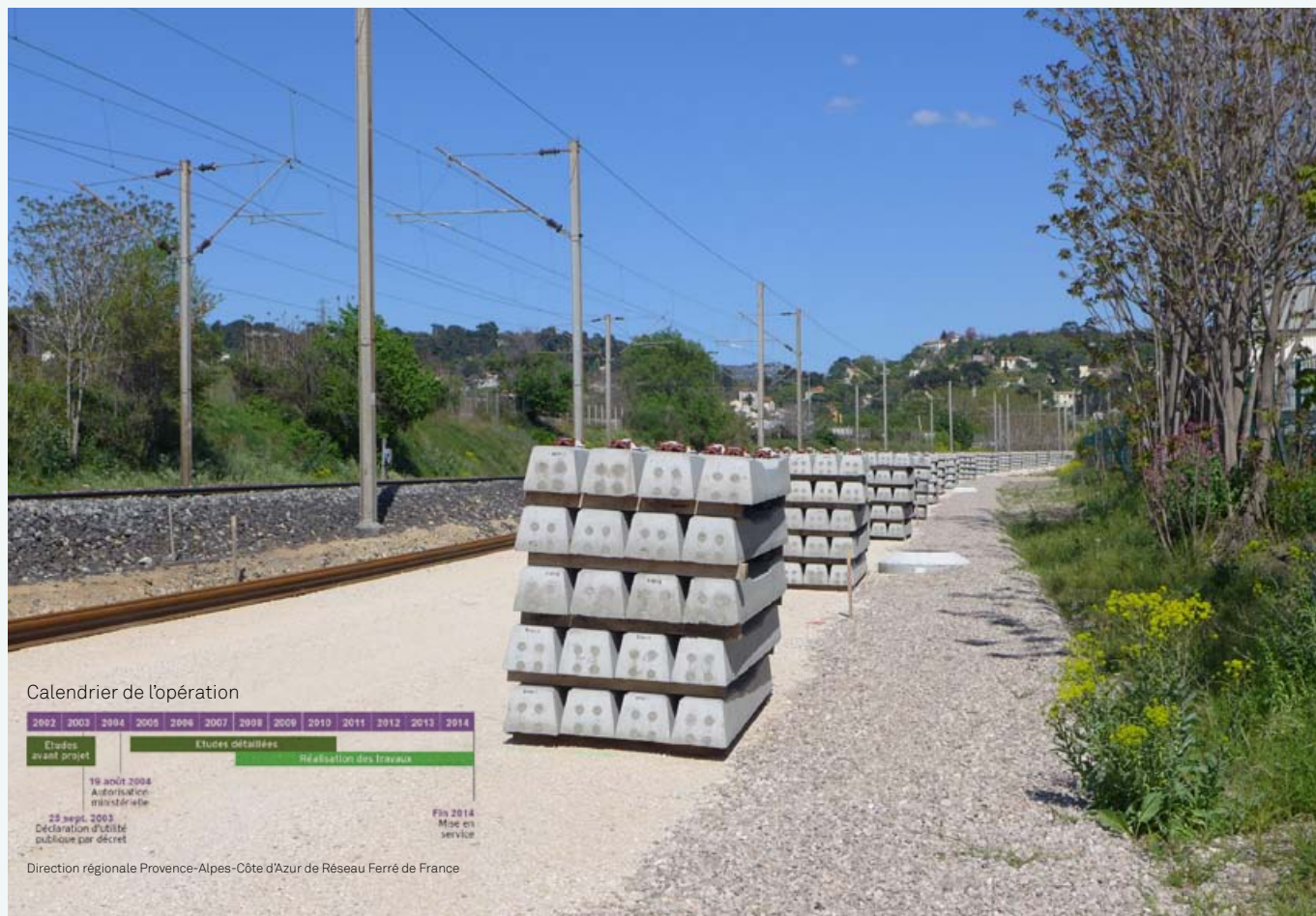
Chantier d'élargissement de la voie ferrée (3 ème voie) dans la vallée de l'Huveaune, avril 2013 (Photo : équipe D-Transect)
