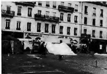
Les installations, protégées de la pluie.
