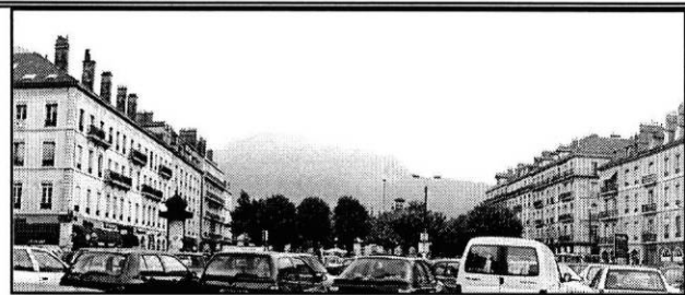
a. Vue ouest
