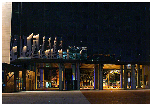
Vue nocturne ouest (détail)
