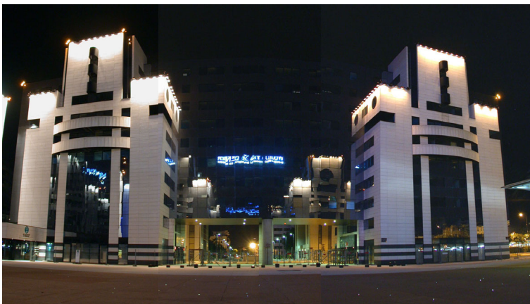
Figure 54 : panorama nocturne Nord - l'éclairage spécifique du porche et l'éclairage public de la rue Doyen Weil
