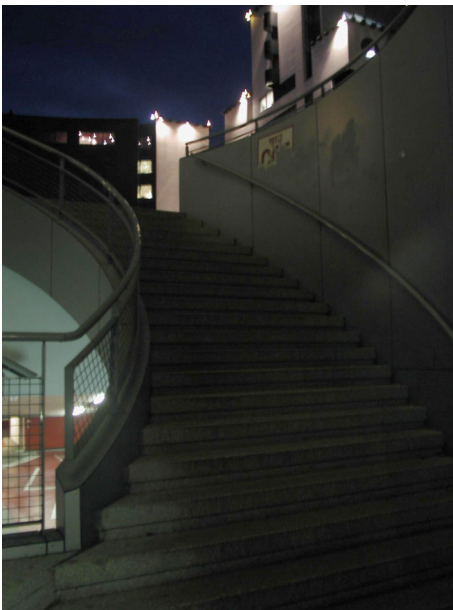
Figure 56 : l'escalier d'accès à la place
