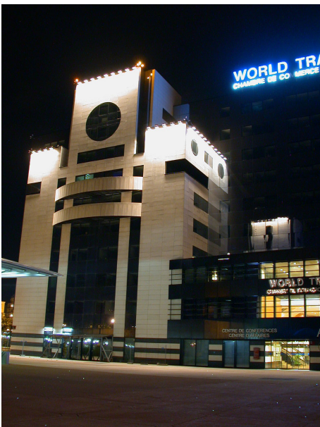
Figure 78 : l'éclairage des façades à son intensité maximum
