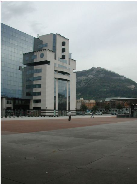
Figure 41 : architecture et traitement de sol
