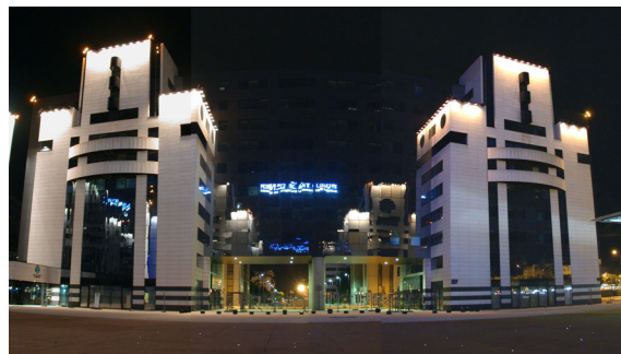
Façade Nord ouverte vers la rue Doyen Weil
