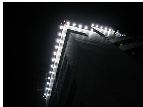
Figure 48 : projecteurs halogènes implantés le long des acrotères
