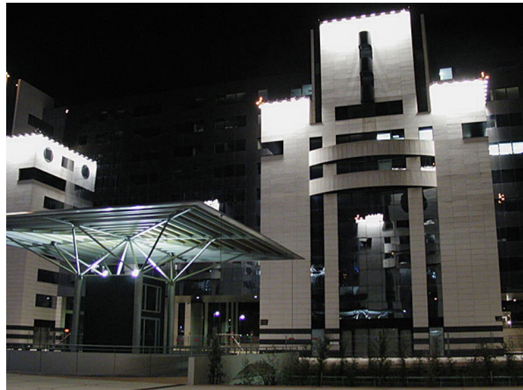
Figure 52 : l’éclairage de l’édicule marquant l’accès à la gare
