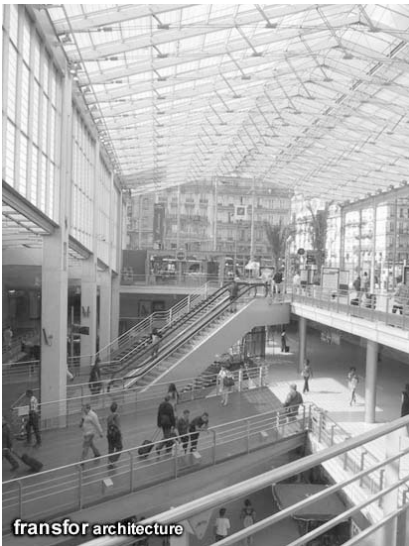
Au premier plan, la passerelle qui conduit au couloir du RER E
