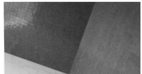
Revêtement de céramique sur 3 parois
