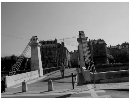
Le "pont suspendu" est une passerelle piétonne.
