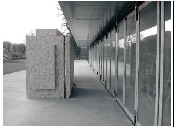
Photo de la « coulisse » entre le prototype et le bâtiment vue du côté de la pièce d'inclusion : l'avancée du bâtiment referme l'espace, les parois vitrées peuvent être ouvertes ou fermées.
