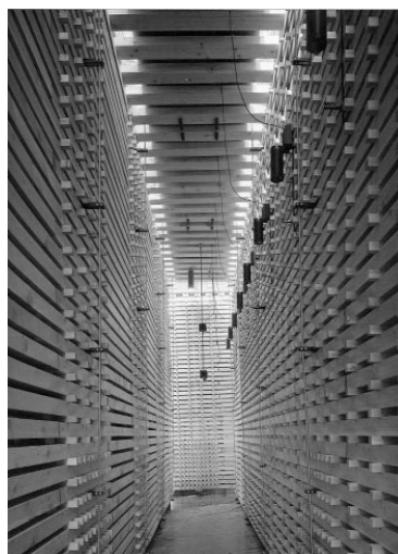
Système lamellé percé à fort pouvoir absorbant
