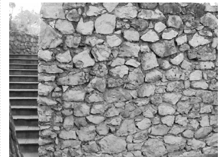
5 - entre les murs, l'escalier apparaît
