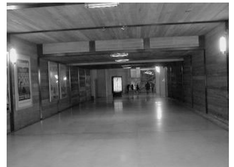
Le couloir : au plafond on voit les caisses absorbantes. Les murs ont eux aussi un traitement acoustique
