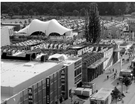
Insertion du pavillon dans l'expo 2000
