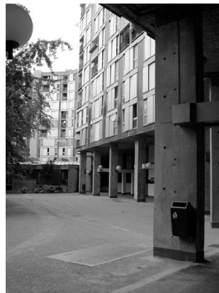
limites de la galerie avec les logements au dessus
