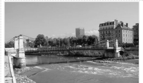
Le pont est une limite à partir de laquelle l'eau s'agit en aval.
