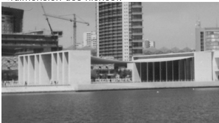
Vue de la partie ouest du pavillon / voile et boîtes
