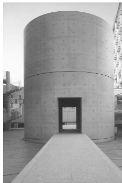
Rampe et ouverture dans le cylindre de béton
