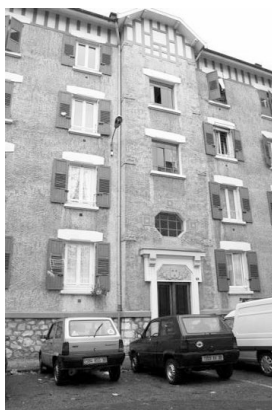
Vue sur l'entrée de l'immeuble et les ouvertures de la cage d'escalier
