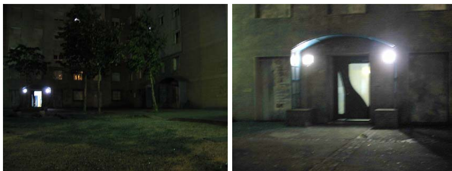
Le pied des tours : espaces délaissés, peu éclairés, contrastant avec les entrées
