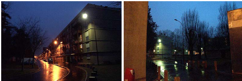
Rue de Menton de nuit : vue générale et ouverture sur le mail entre les bâtiments n°18 et 27
