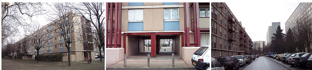
Le n°27 côté mail et côté rue de Menton. Au centre, le porche permettant de traverser de l'un à l'autre
