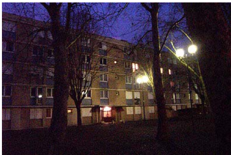
L'éclairage des globes source de gêne
