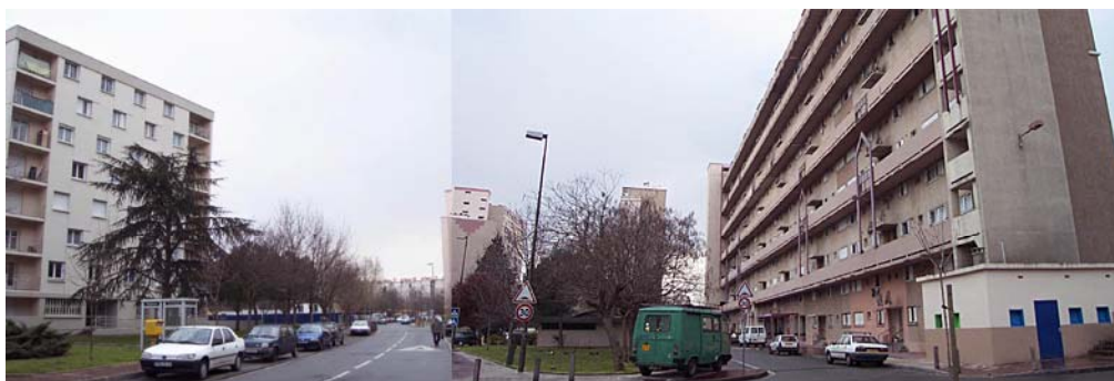
Accès au quartier par le nord de l'avenue J. Moulin : perception de l'effet "Muraille"
