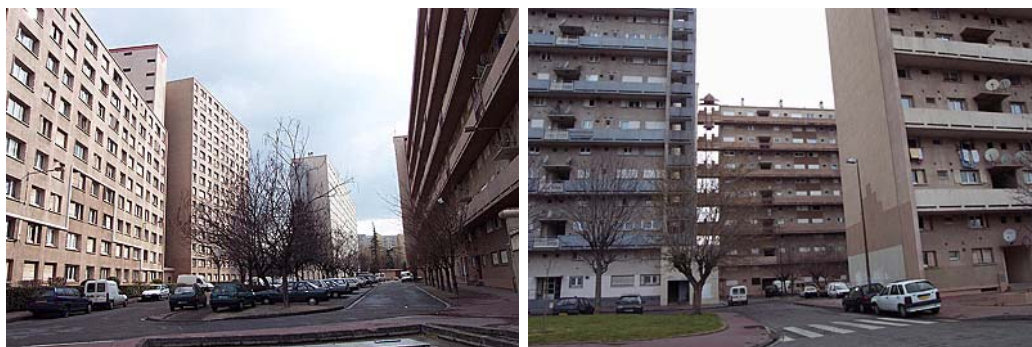
La succession des barres à l'intérieur du quartier : densité et manque d'identification des espaces
