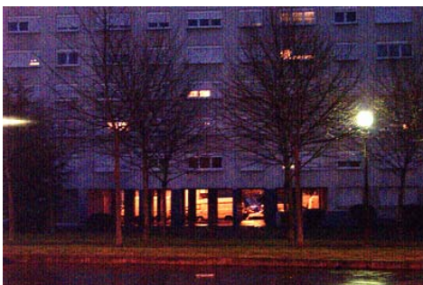
Les porches éclairés, lieux d'évitement
