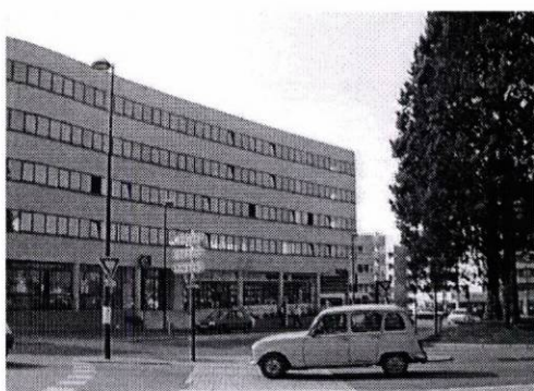
3 • vue à partir du rond-point - bât. adm. (107)
