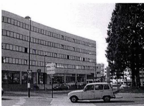
3 • vue à partir du rond-point - bât. adm. (107)
