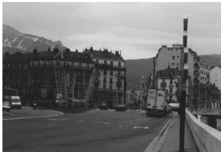
1 - pont et Porte de France
