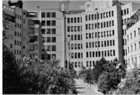
32 - passage à travers l'îlot, sur la dalle
