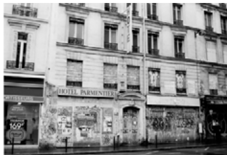
2 - Quartier en rénovation - 91 rue Oberkampf
