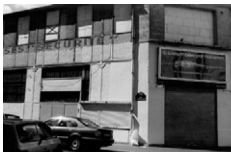
17 - Entreprise murée à l'angle des rues Oberkampf et Crespin du Gast
