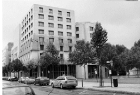
10 - Bâtiment de Gehry (Centre américain et futur Maison du cinéma) et vue sur le parc - depuis la rue de Bercy
