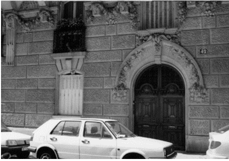
17 - Rue Decamps, immeuble aux têtes de bélier
