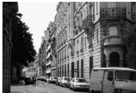
16 - Rue Decamps, vers la rue de la Pompe
