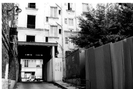
3 - Chantier dans la cour du n° 93 rue Oberkampf
