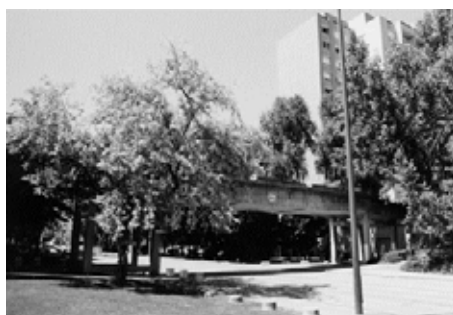
15 - Passerelles avenue La Bruyère
