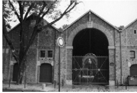
26 - Rue des Pirogues de Bercy - chantier Bercy-village et au loin, cinéma UGC
