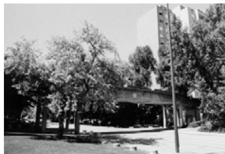
15 - Passerelles avenue La Bruyère
