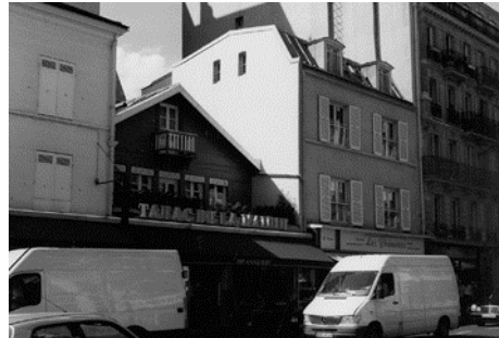
20 - Rue de la Pompe - chalet
