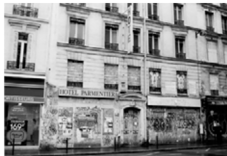
2 - Quartier en rénovation - 91 rue Oberkampf
