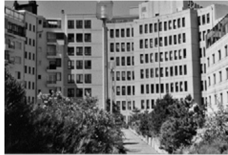
32 - passage à travers l'îlot, sur la dalle
