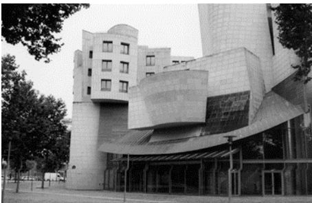
11 - Bâtiment de Gehry, entrée côté parc
