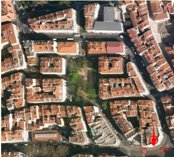
Vue aérienne sur la place Sathonay à Lyon
