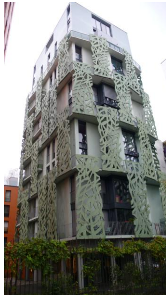
Paris 05. Square Georges-Duhamel ; limite entre le square public et les rez-de-chaussée privés
