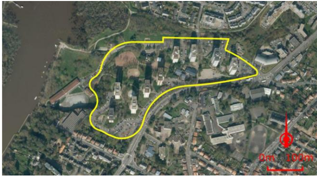
Vue aérienne sur les HLM de Port-Boyer à Nantes
