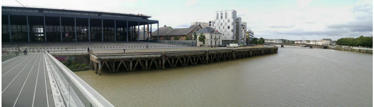
Figure 17 : Photographie du quai situé au pied du Palais de Justice depuis la Passerelle Victor Schœlcher. Ce quai est rendu par un « effet de nappe » dans l'illustration précédente (voir Figure 16).
