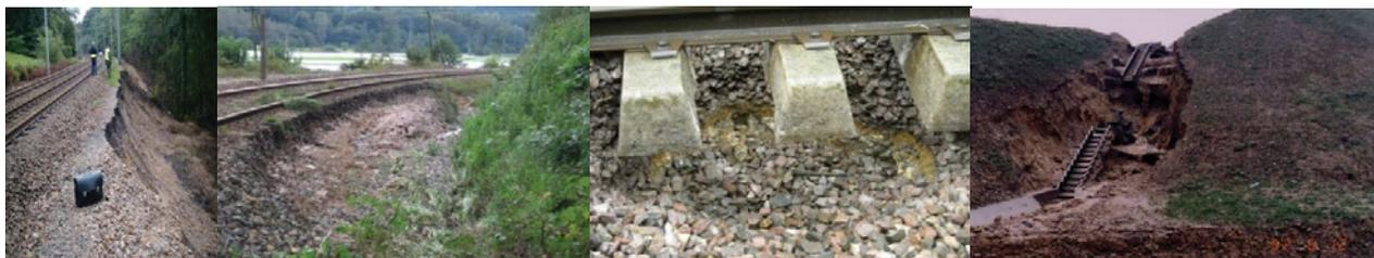
Figure 1 : Illustrations d'incidents graves : érosions de plateforme, de talus ou de remblais (Ingénierie SNCF Infra).
