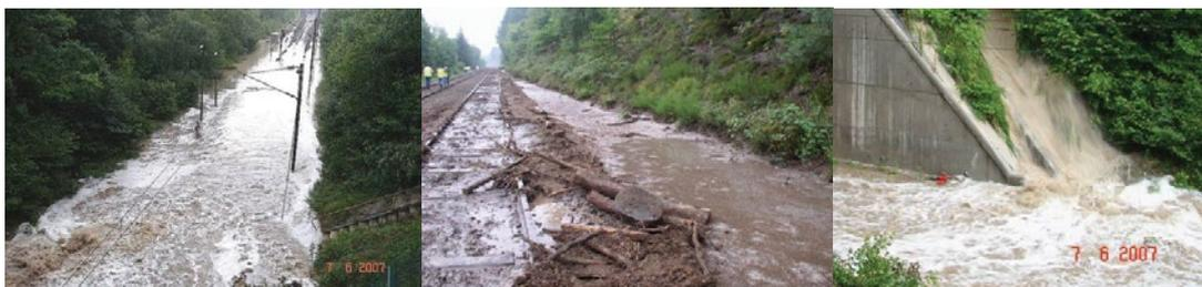
Figure 2 : Illustrations d'incidents graves : inondation et coulées boues (Ingénierie SNCF Infra).
