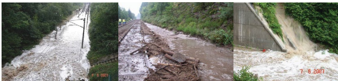
Figure 2 : Illustrations d'incidents graves : inondation et coulées boues (Ingénierie SNCF Infra).
