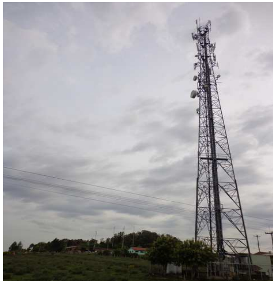
Figura 1 - Antena de telefonia móvel
