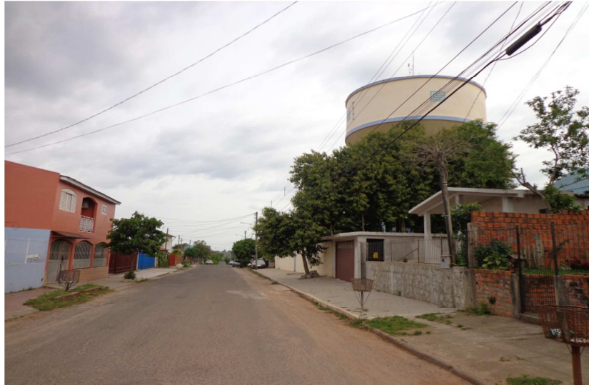
Figura 4 - Caixa D'água da Companhia de Água e Esgoto
