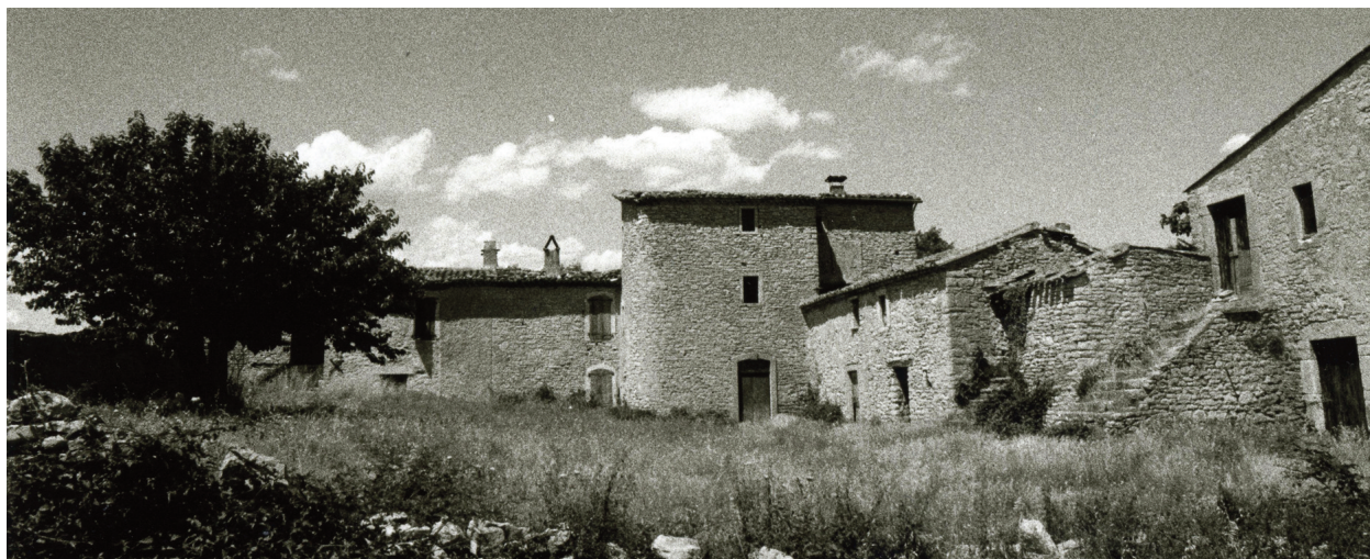
Fig. 3. Ferrières-les Verreries ; vue générale, depuis le sud, des bâtiments principaux de la métairie de Baumes-Groupe I. L'arbre occupe l'emplacement de l'atelier. © A. Riols/ODAC 1993.
