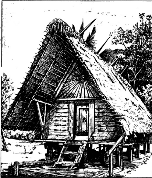
Fig. 9. Maison construite sur pilotis en prévision des inondations.
